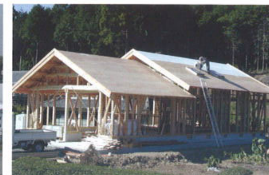
瓦屋根家の野地板に塗布。
