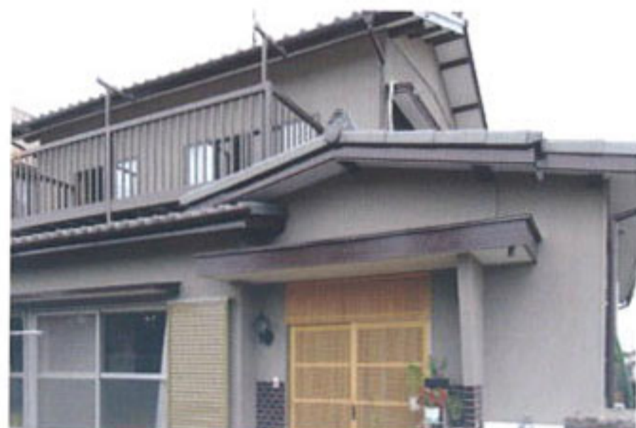
K 邸：塗布箇所/内壁・天井：40㎡、外壁：260㎡。
