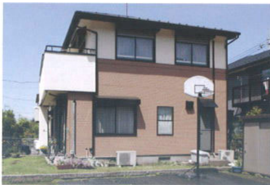
O邸：塗布箇所/屋根：90.9㎡、外壁：156.95㎡。
