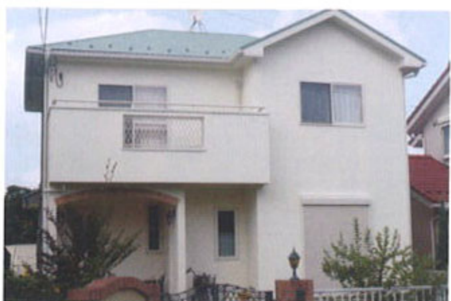
S 邸：塗布箇所/屋根：94㎡、外壁：140㎡。
