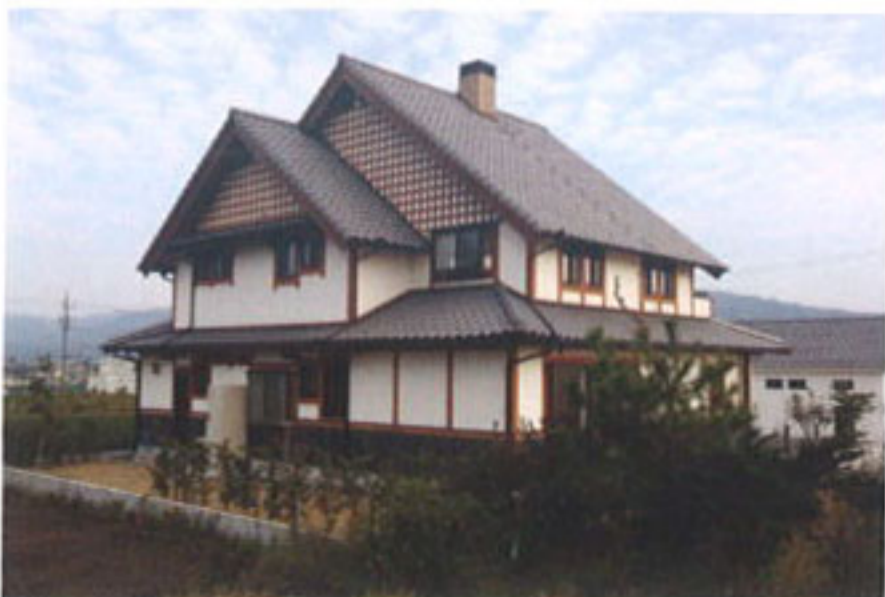
T 邸：塗布箇所/屋根：300㎡、外壁：180㎡他。
