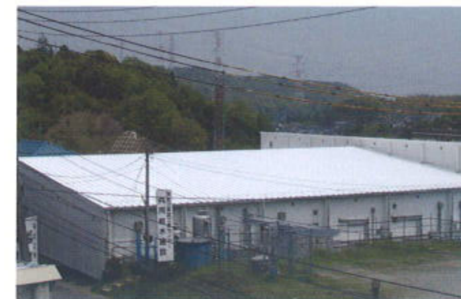
冷蔵倉庫屋根に塗布。
